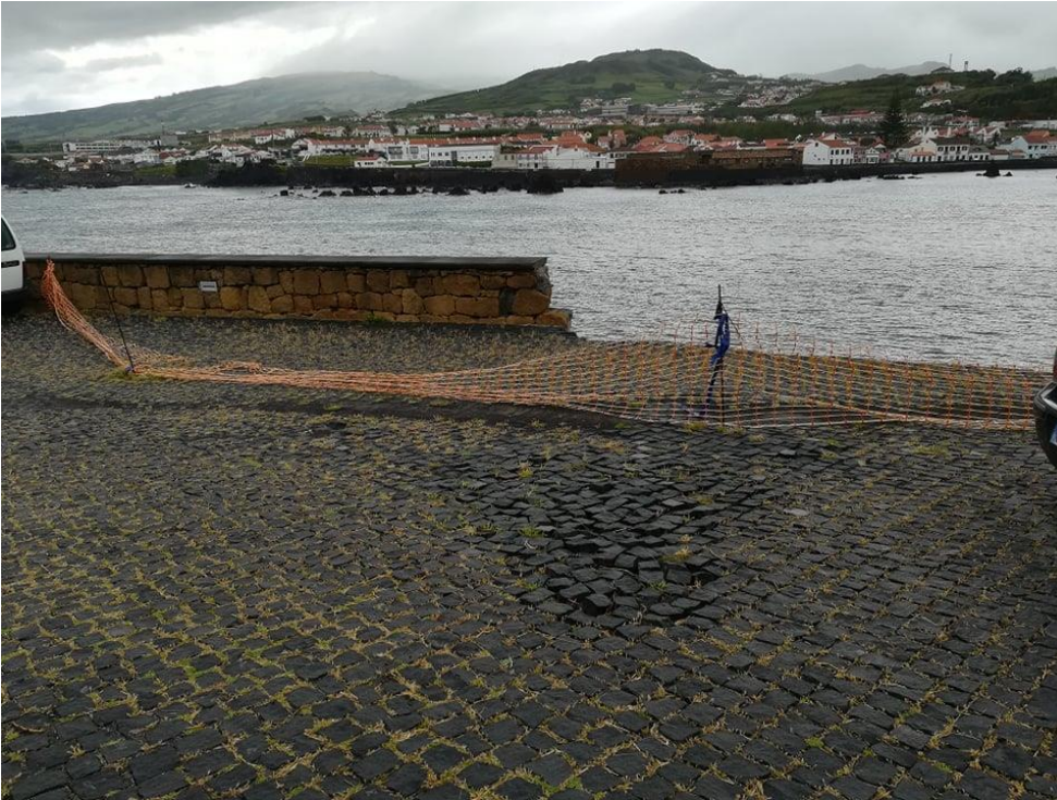
Fig. 1- Vedação insuficiente, a sinalização feita do local com as intempéries deixa praticamente de existir.
