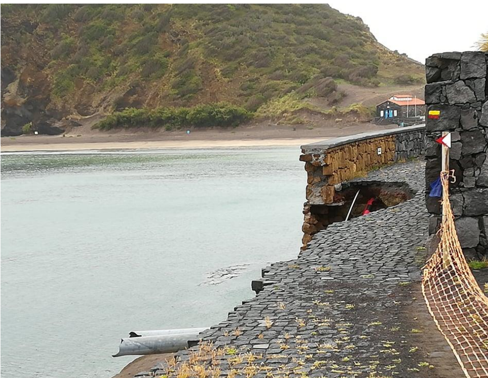
Fig.2- Derrocada que se deu com a passagem do Furacão Lourenço, nesta imagem podemos ver a sinalização do trilho oficial, cabos de alta tensão e tubos
